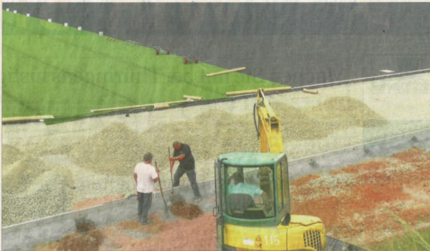
Das erste Grün ist auf dem neuen Kunstrasenplatz in der Bad Lobensteiner Poststraße verlegt worden. Die Arbeiten an der Sportanlage sind in den vergangenen Wochen zügig voran gegangen. Foto: Joachim Jasinski
