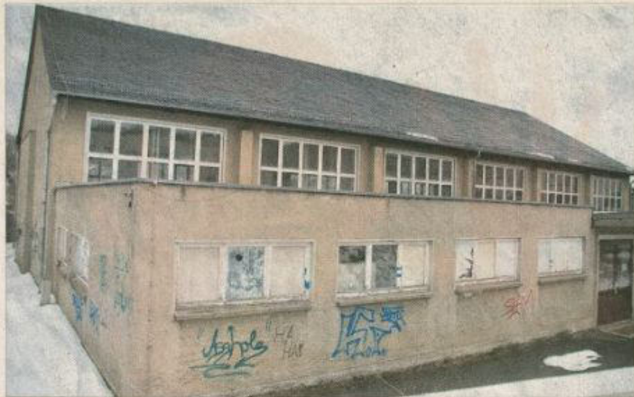
Von Unbekannten wurde in den vergangenen Wochen, das letzte Mal erst am vergangenen Wochenende, die alte Turnhalle heimgesucht. Das Landratsamt in Schleiz empfiehlt einen baldmöglichen Abriss. (Foto: [4]: Mike Finke)
