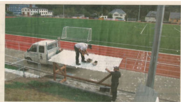
Die Thüringer Dankenkommis von Thom Weltfarth hat gestern beide Überdachungen für die Trainer- und Auswechslerkabine am Rande des neuen Kunstrasenplatzes fertiggestellt. Foto: Sven Heinz Pulzmann
